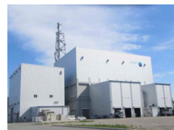
《赤穂第2バイオマス発電所》
